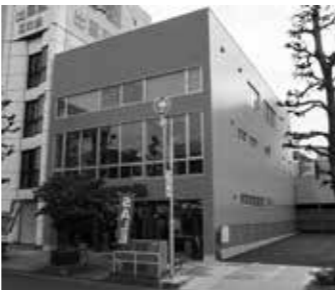
店舗は3階建てだが、3階の中央部分は屋根なしの屋上造りになっていて、バーベキューなどのイベントも画策中とのことだ
